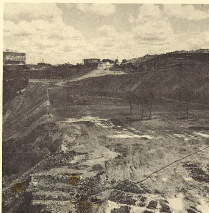
PATAMAR DAS QUADRAS DE TÊNIS
