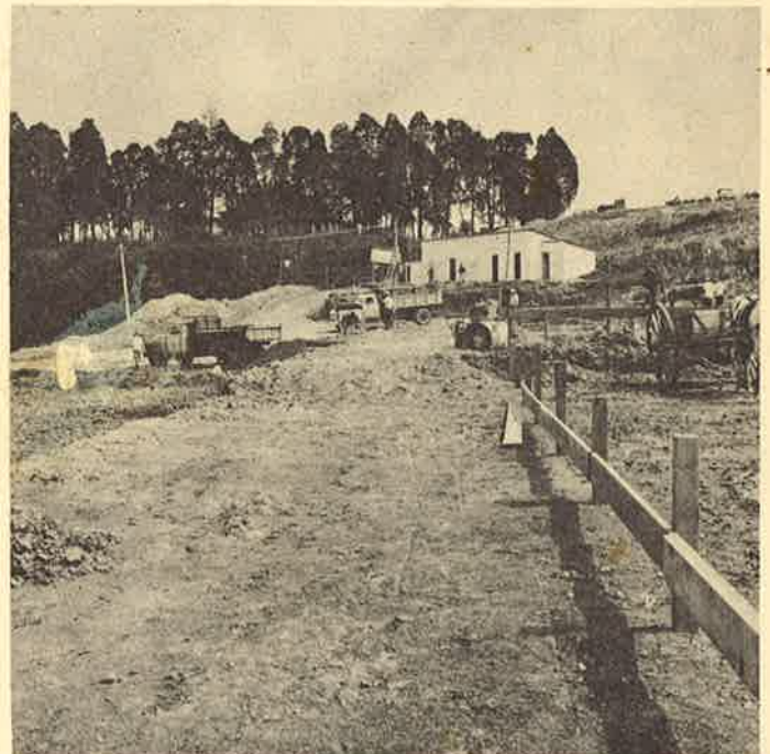
DEMARCAÇÃO DA PLATAFORMA DAS PISCINAS
