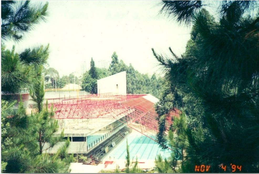
Montagem da estrutura metálica da cobertura do Conj. Poliesportivo 1996
