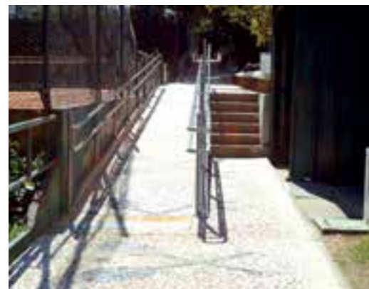
Construção de rampa para acessibilidade
