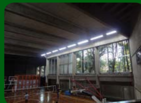
Iluminação LED Ginásio Velho
