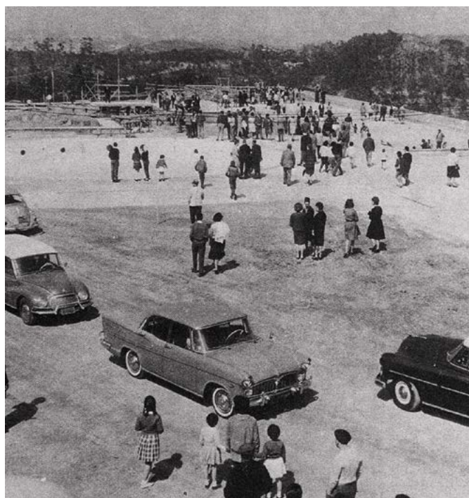
Terreno e início das obras – 1960 – acervo
