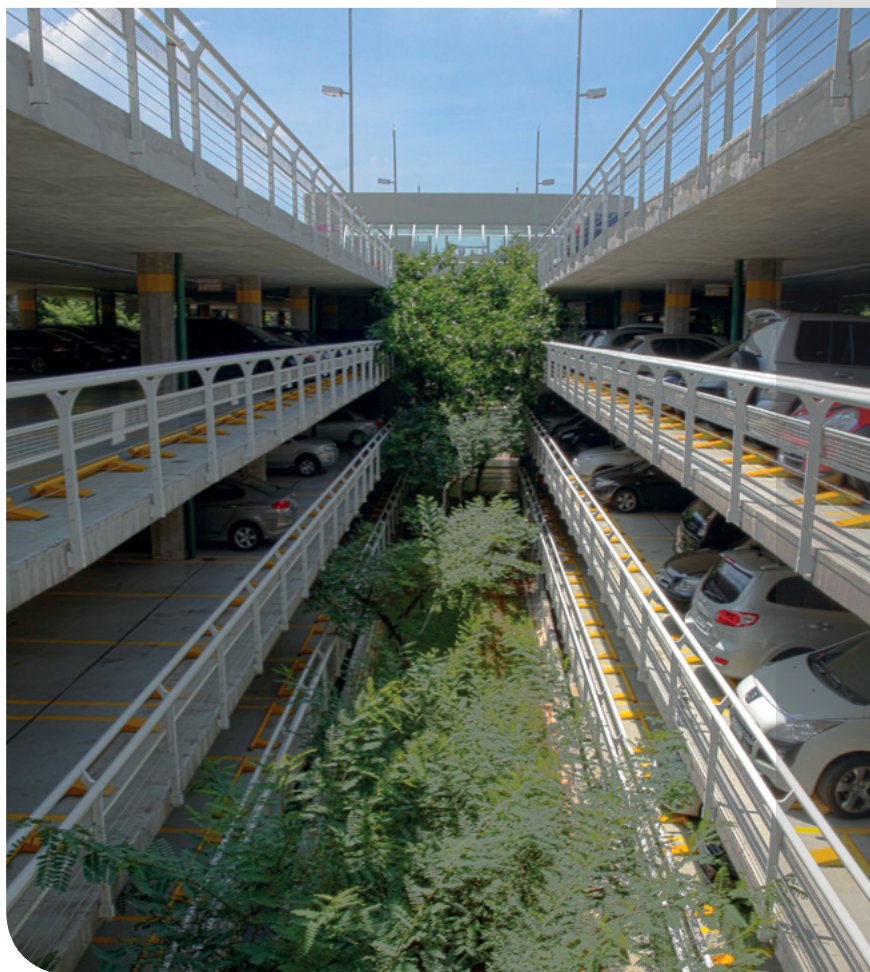
INTERIOR DO ESTACIONAMENTO
