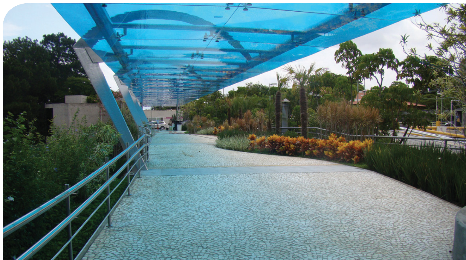
PASSARELA DE INTERLIGAÇÃO DO ESTACIONAMENTO À SEDE SOCIAL
