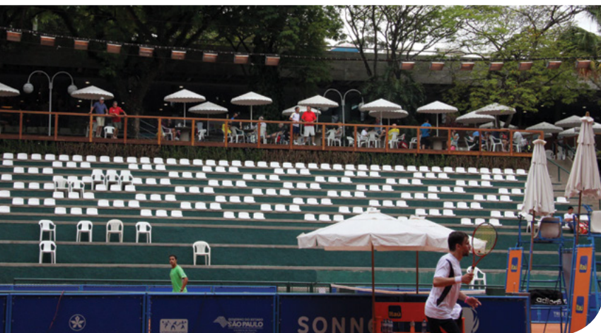
DECK E ARQUIBANCADA DAS QUADRAS DE TÊNIS PRINCIPAIS
