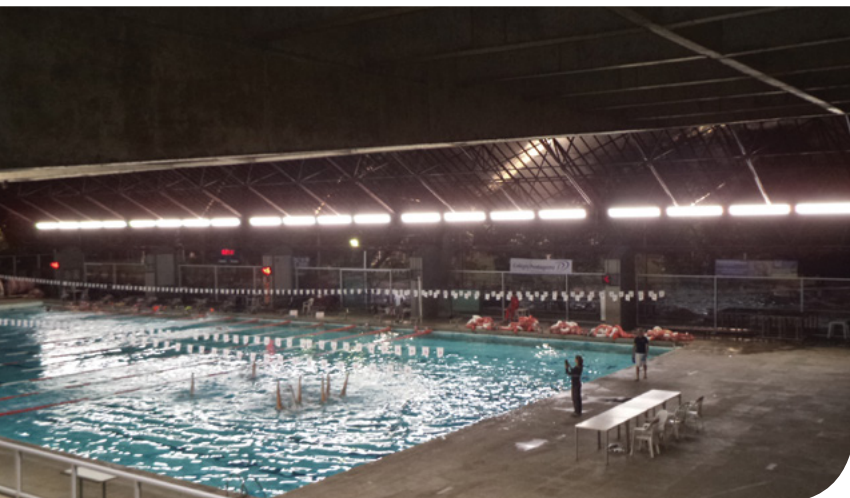
NOVA ILUMINAÇÃO POR LED DA PISCINA OLÍMPICA
