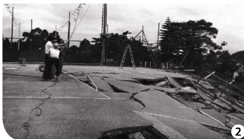
Fotos 1 e 2: Desmoronamento das quadras de tênis 6 e 8 visto da atual plataforma infantil
