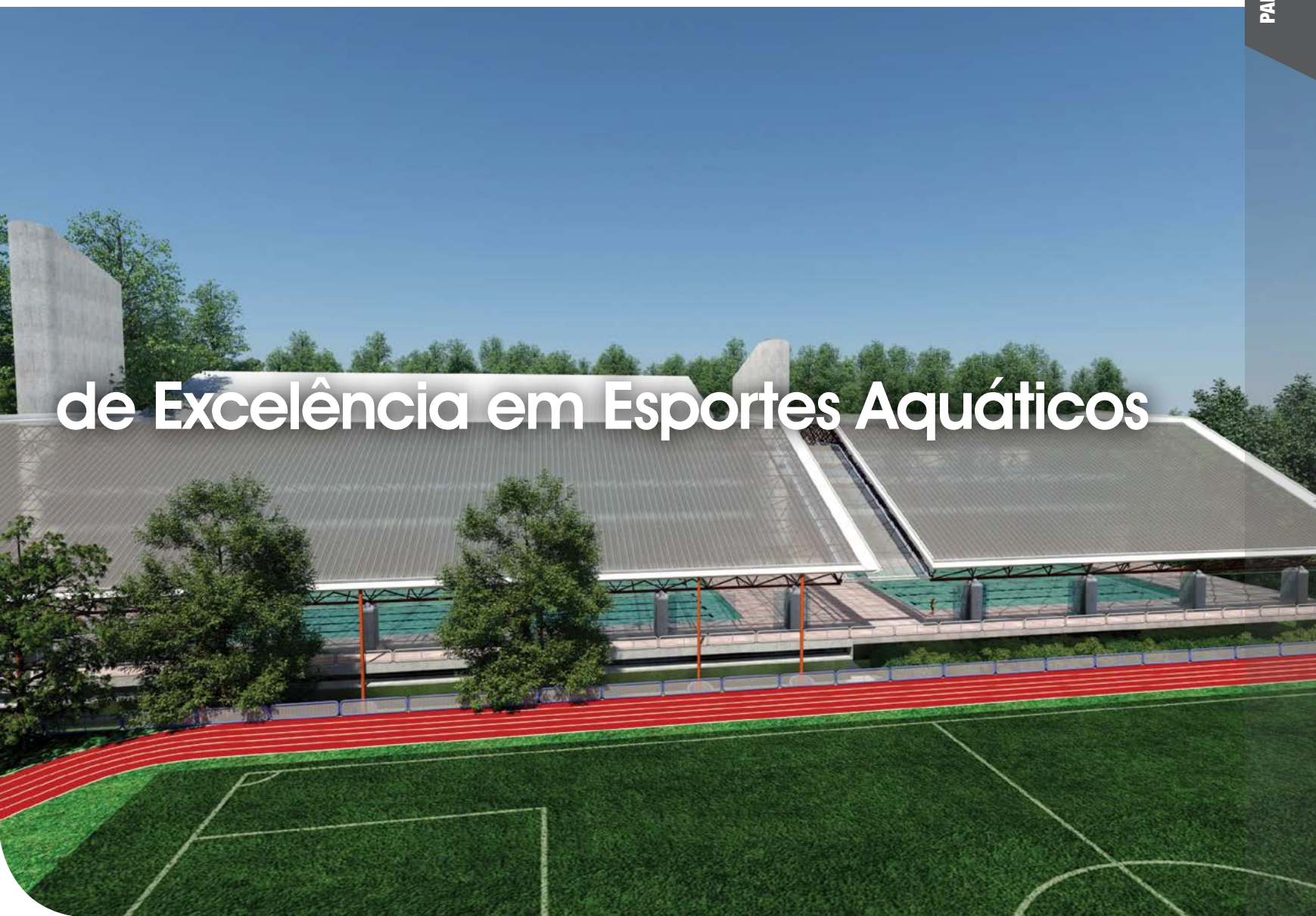
Fachada do Complexo Aquático Ampliado
