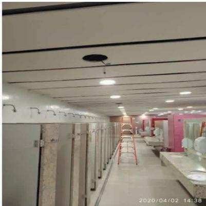
• Melhorias gerais no sistema de iluminação, incluindo a troca de refletores convencionais por refletores LED:
